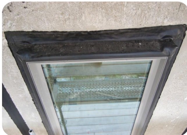
Bovenaanzicht EPDM manchet rondom kozijn op binnenblad
