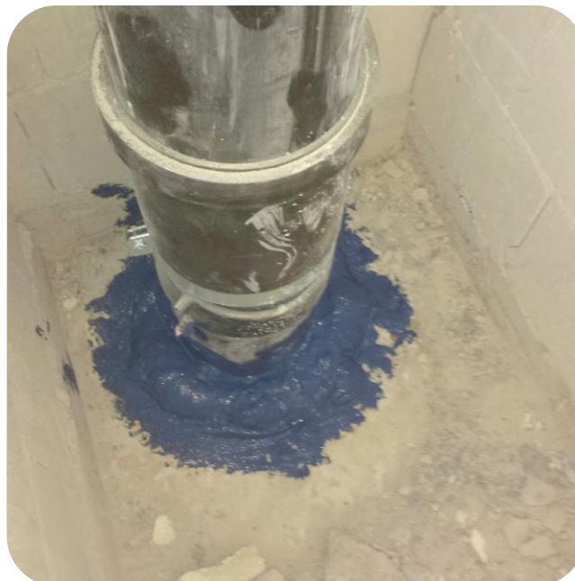
Afdichting buisdoorvoer
