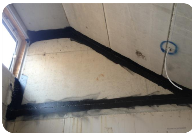
Afdichting wand-plafond aansluiting
