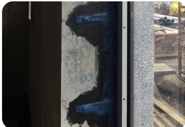
Dagkant kozijn op het binnenspouwblad
