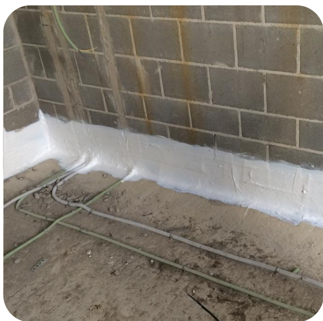
Afdichting vloer-wand aansluiting (wit)
