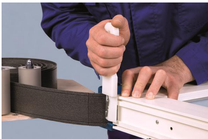
Ter plaatse van hoeken de achterzijde insnijden met een stanleymes met haakmesje
