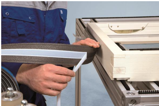
Aanbrengen op een houten kozijn middels de butyllaag, aanvullend vastnieten in de zijstroken
