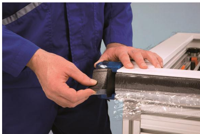
Het verwijderen van het ingesneden gedeelte van de rug van het compressieband
