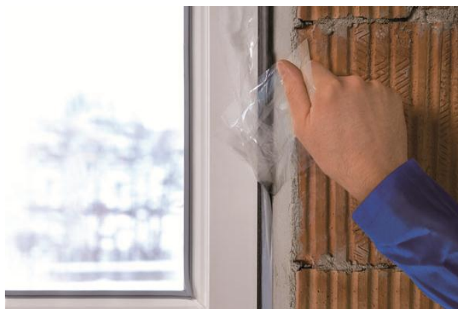
Na plaatsing van het element de folie verwijderen waarna het band zal uitzetten
