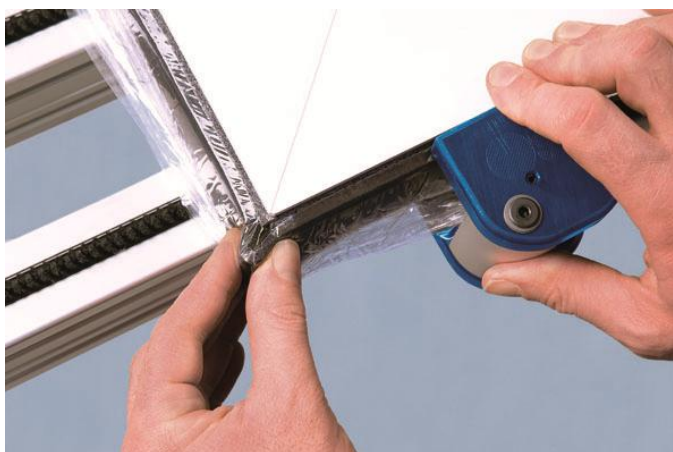
Creëer een lus met het compressieband voor een goede afdichting van de hoeken
