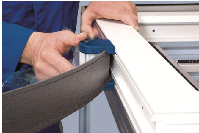
Aanbrengen op een kunststof kozijn, geklemd in de profilering met behulp van het speciale hulpstuk
