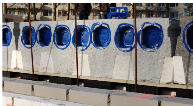
Akoestische ontkoppeling van een geïsoleerde kanaalplaatvloer d.m.v. Mavo-dBreak Isostruct
