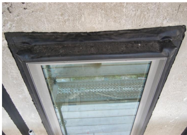
Bovenaanzicht EPDM manchet rondom kozijn op binnenblad
